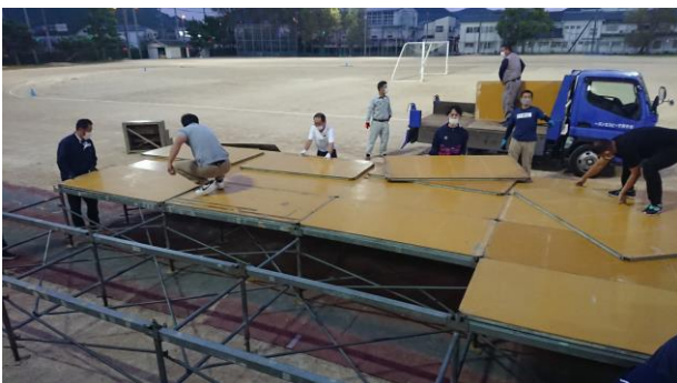
10/12 PTAが特設ステージを設営している様子
