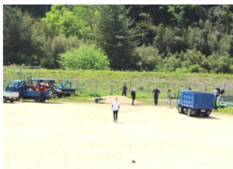
5月2日（月） 草捨て場の草木撤去作業
